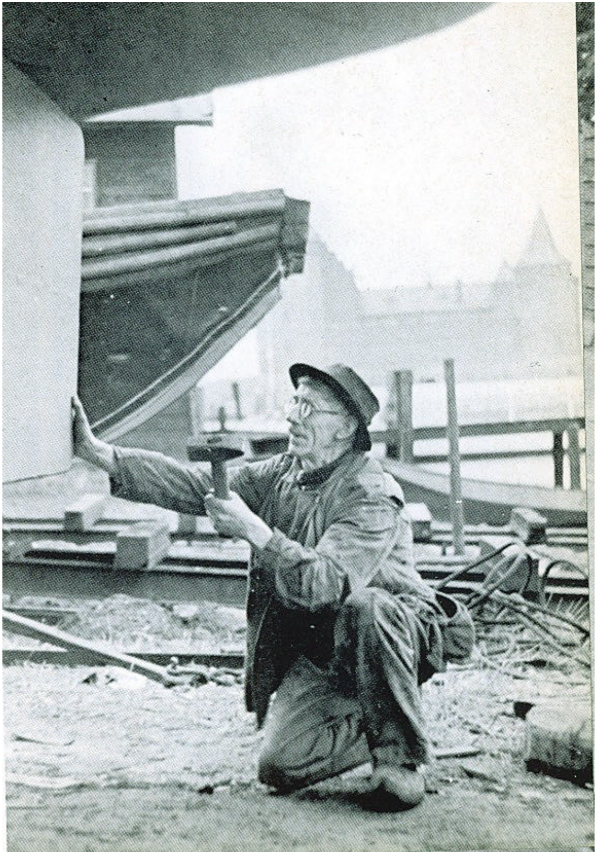
Jaap (van) Aalst, "huitar" bij scheepswerf Schouten van zijn 15e tot zijn 72 e , hier aan het werk. Hij maakte de overgang mee van hout naar staal en zwaaide van de vroege morgen tot de late avond zijn sterke armen met de hamer om de huidplaten te laten bollen. In de jaren zestig kwamen er op verzoek Spaanse gastarbeiders uit Gijon en omgeving naar Muiden. Ze kregen een woning van Schouten in Wijk Noordwest en bleven er vaak tot hun dood of de dag van vandaag wonen.
